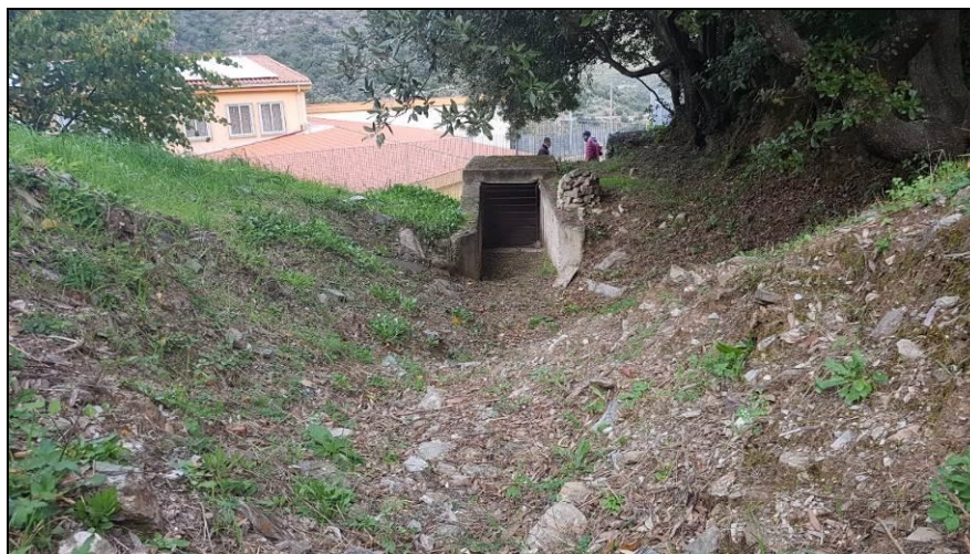
Figura 4 – Immissione del tratto tombato del Riu Sa Pira, a monte della scuola di via Europa
