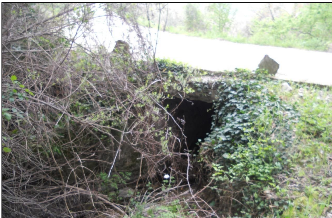
Figura 17 Primo attraversamento sul Riu Erriera
