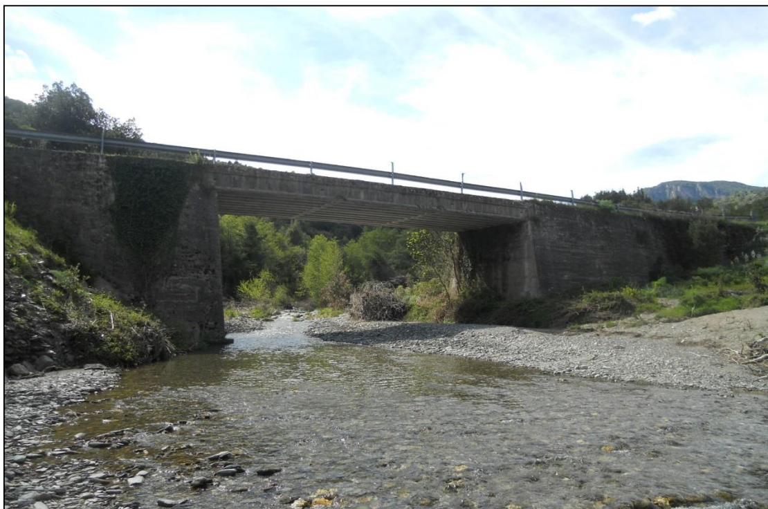
Figura 23 Attraversamento sulla Strada demaniale Niala
