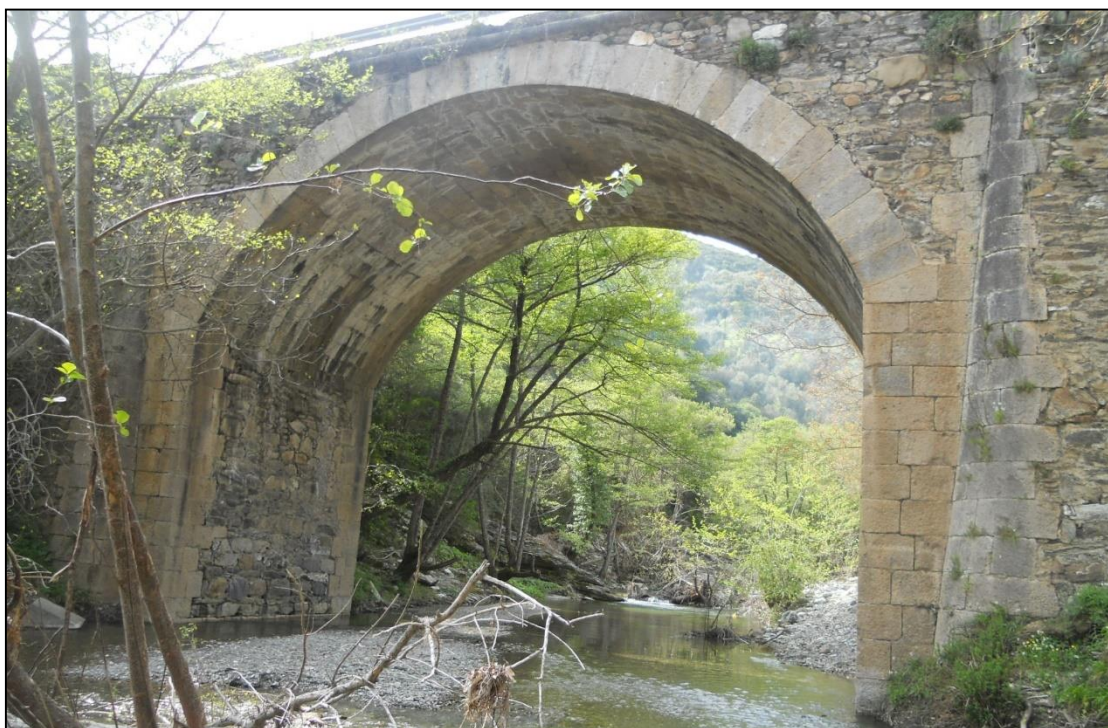
Figura 22 Attraversamento sulla S.S.198
