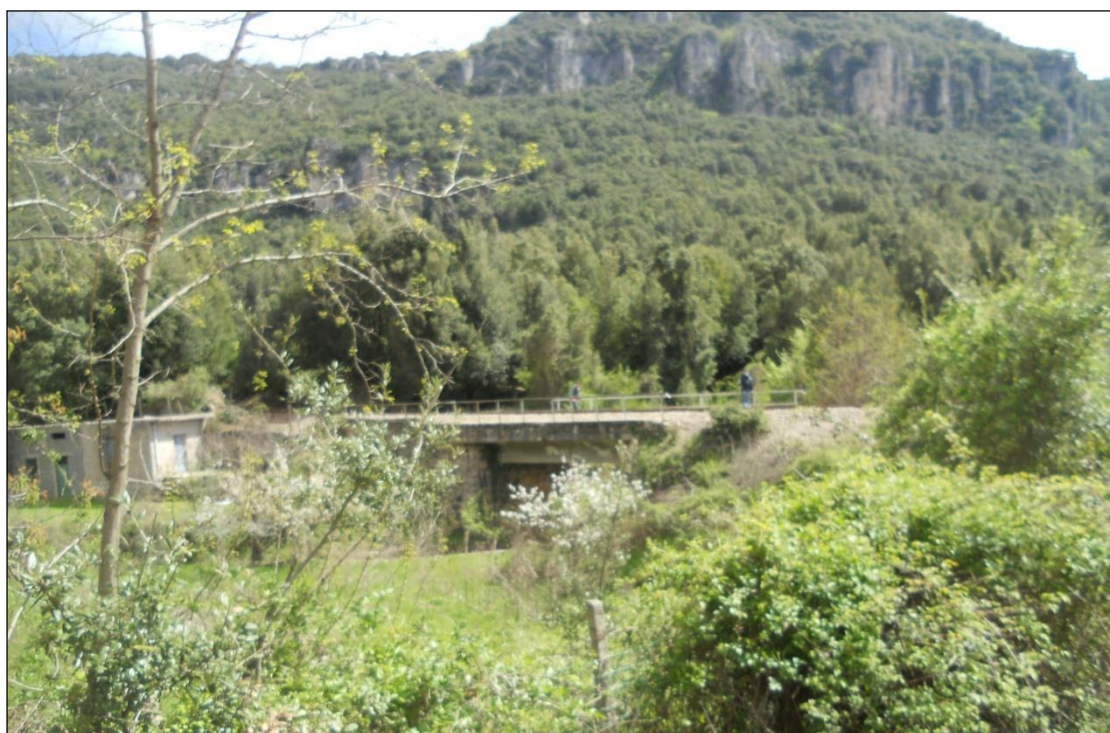
Figura 13 Ferrovia sul Riu Taquisara
