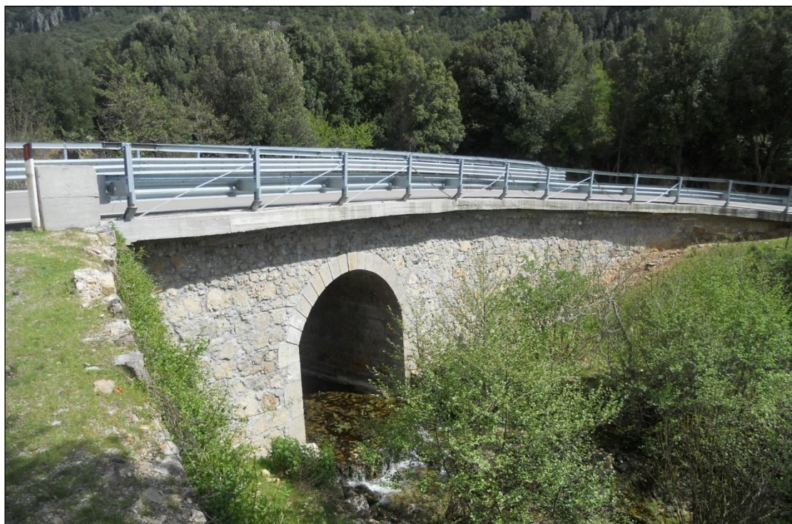
Figura 12 Ponte sul Riu Taquisara
