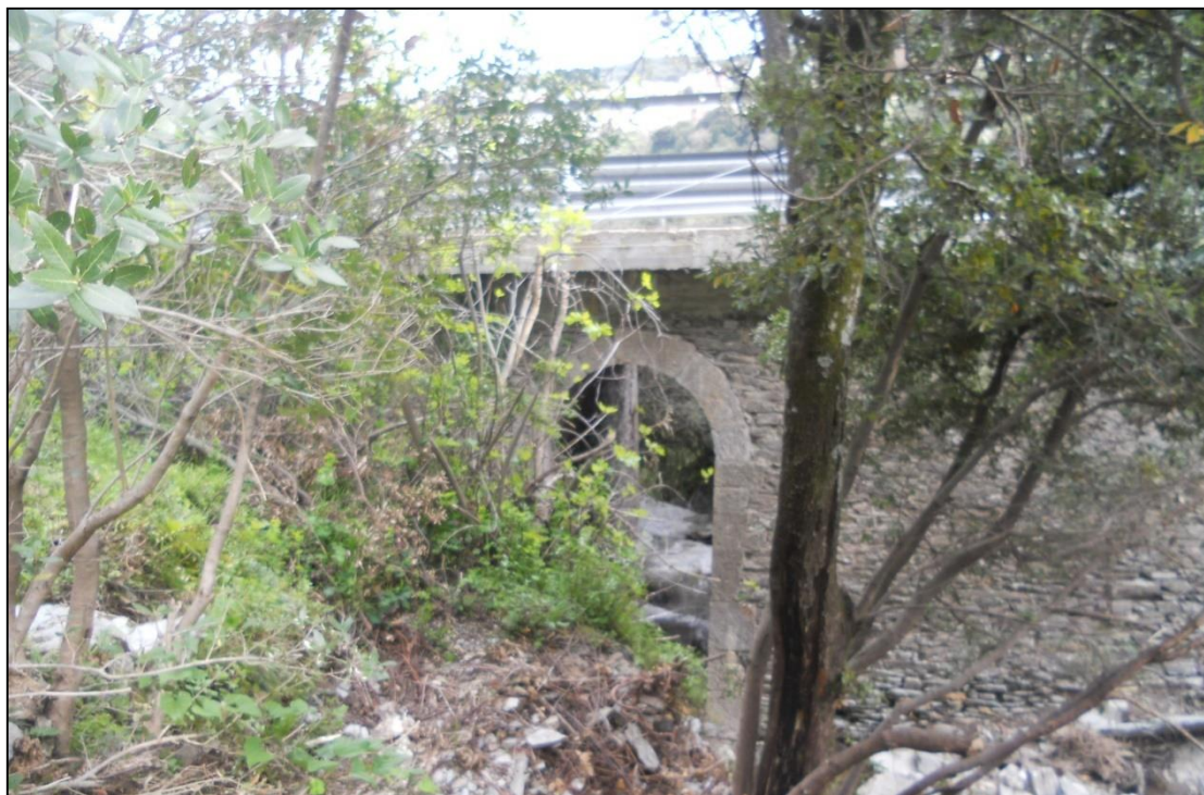
Figura 14 Ponte sul Riu Laccasei
