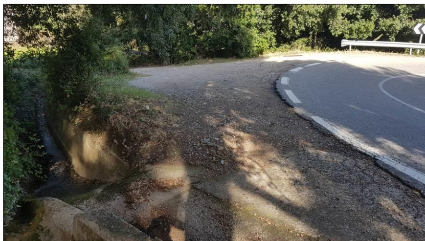
Figura 4 – Opere di collettamento esistenti lungo la SS 189, per convogliare gli apporti meteorici verso lo scarico esistente (bacino 2)
