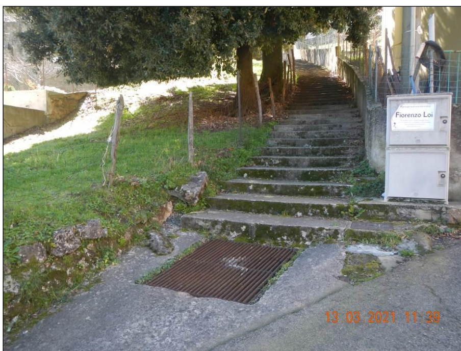
Figura 10 - Griglia di raccolta, ubicata lungo via San Giovanni Bosco. Lo scolare in progetto avrà origine da tale punto
