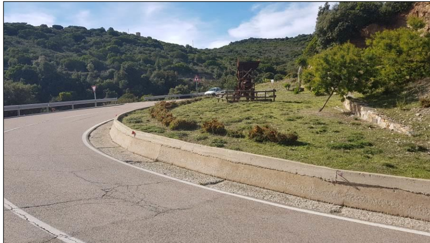
Figura 1 – Ripresa fotografica in corrispondenza del primo tornante lungo la SS 189. In questo tratto di strada è presente la cunetta alla francese che consente il collettamento delle acque meteoriche afferenti alla piattaforma stradale
