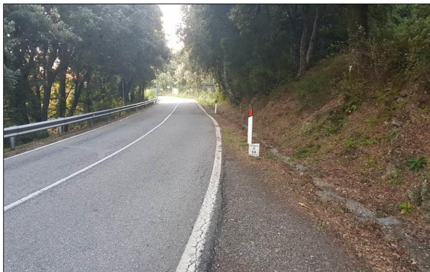
Figura 8 – Ripresa fotografica lungo la SS 198, prima dell’abitato di Ussassai. In tale tratto non è presente nessun elemento volto al collettamento delle acque meteoriche
