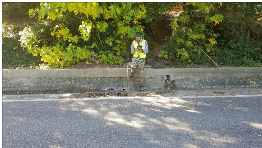
Figura 3 – Ubicazione della griglia presente lungo la SS 189 che converte lo scarico delle acque meteoriche verso “l’impluvio C”. Tale griglia, allo stato di fatto delle opere, viene parzialmente intasata dal materiale flottante (foglie) in occasione di eventi meteorici intensi, e causa quindi il convogliamento della maggior parte degli afflussi verso “l’impluvio B”
