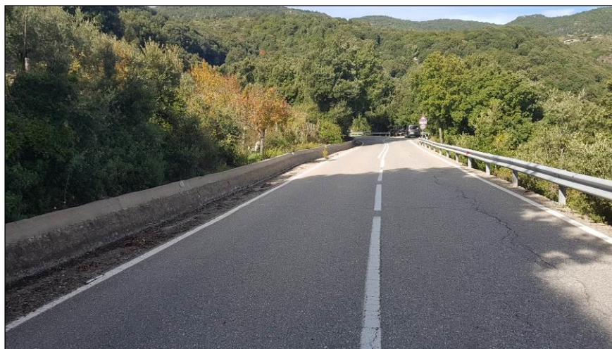
Figura 2 – Ripresa fotografica lungo la SS 189. In tale tratto è presente la cunetta alla francese e un muretto per evitare che le acque di versante raggiungano la piattaforma stradale
