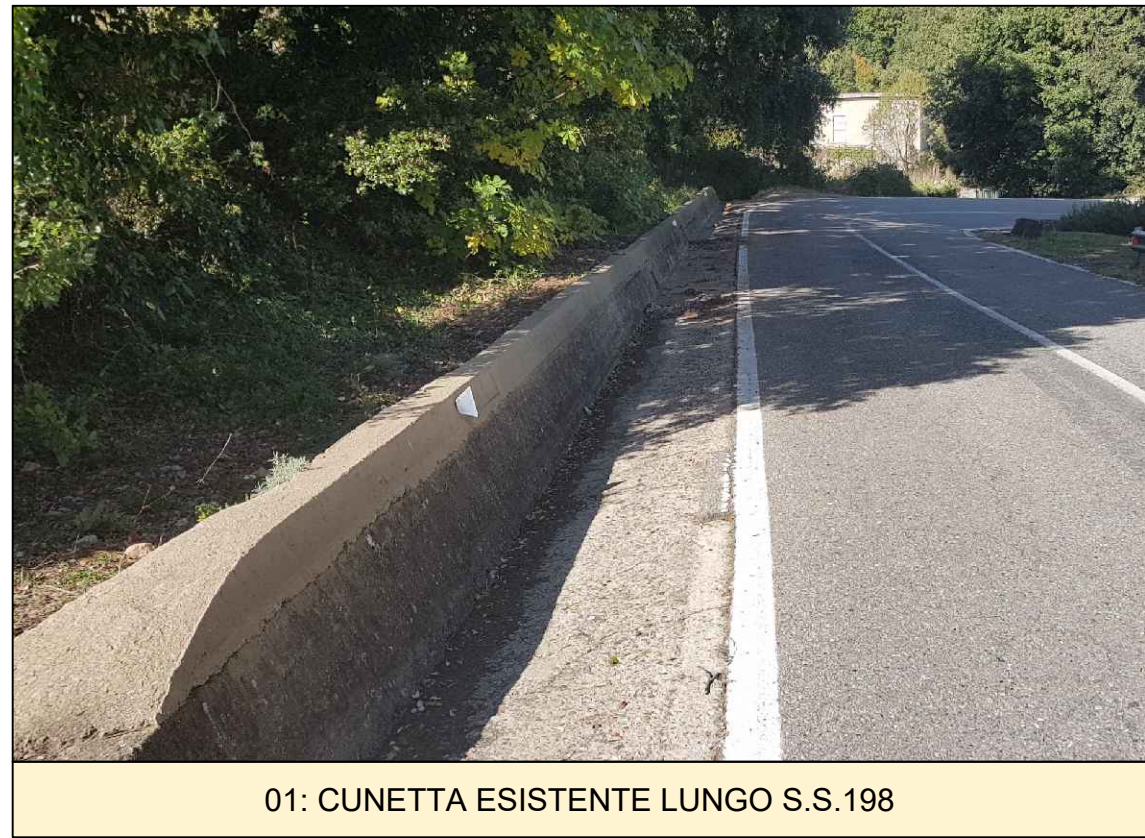
01: CUNETTA ESISTENTE LUNGO S.S.198
