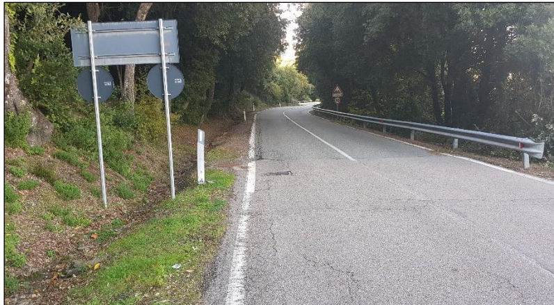
Figura 21 – Vista lungo la SS 198, poco prima dell’abitato di Ussassai
