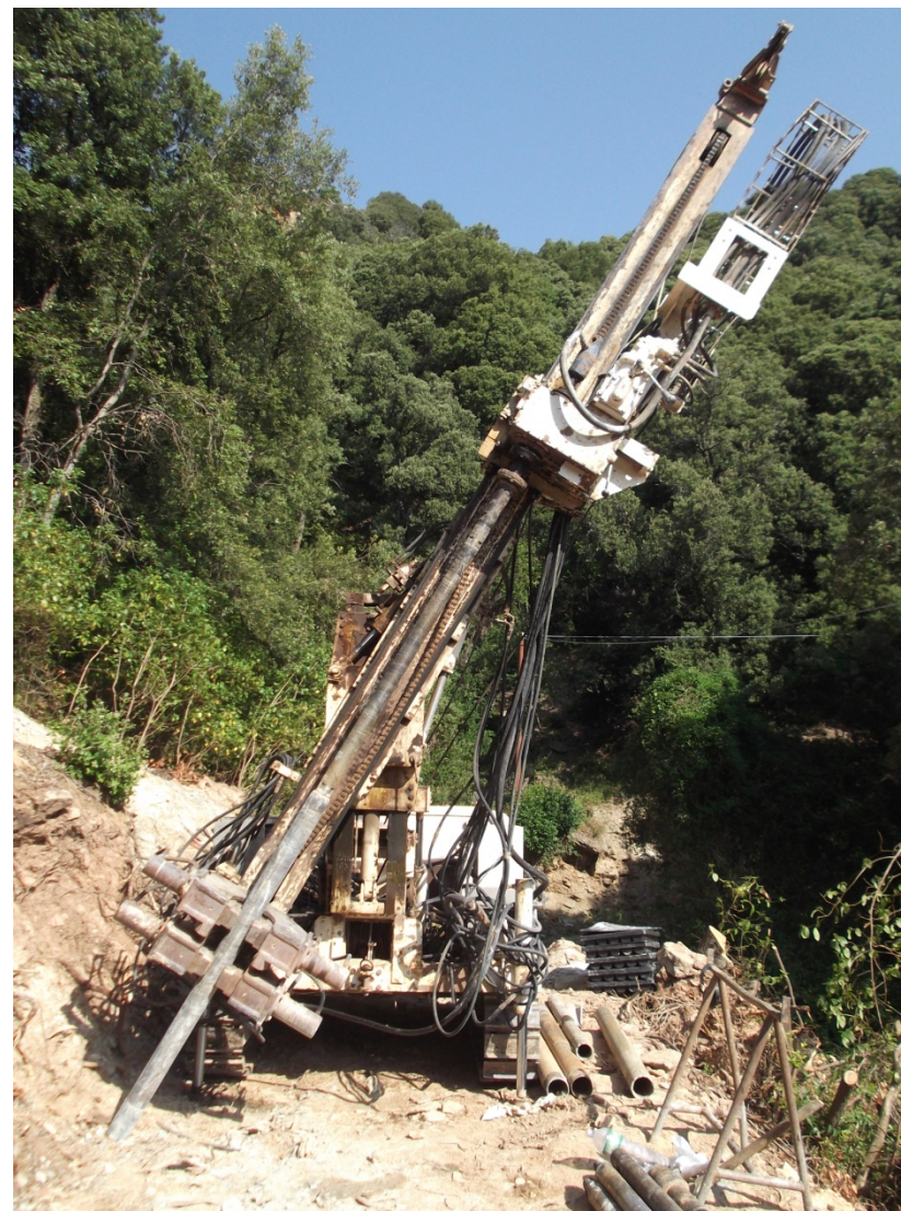
Foto 8 – Trivella in esecuzione sondaggio S3 inclinato
