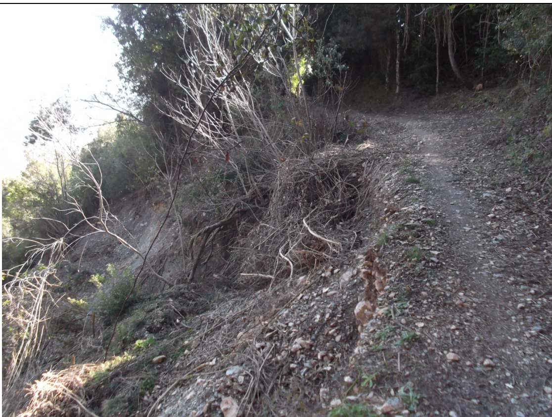
Foto 2) sentiero residuale della viabilità a seguito del movimento franoso
